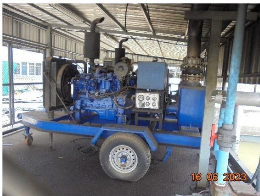
รูปที่ 32 เครื่องสูบน้ำขนาด 300 ลบ.ม./ชม.
